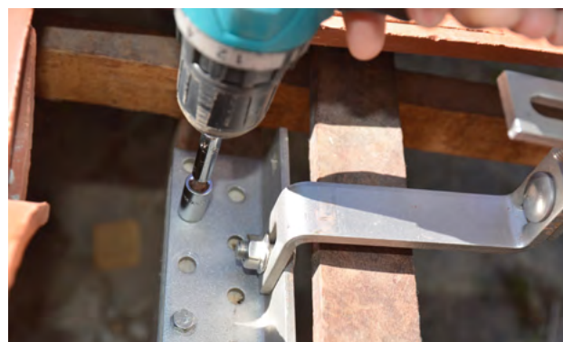
Figura 134. Montagem da fixação do gancho no caibro.
