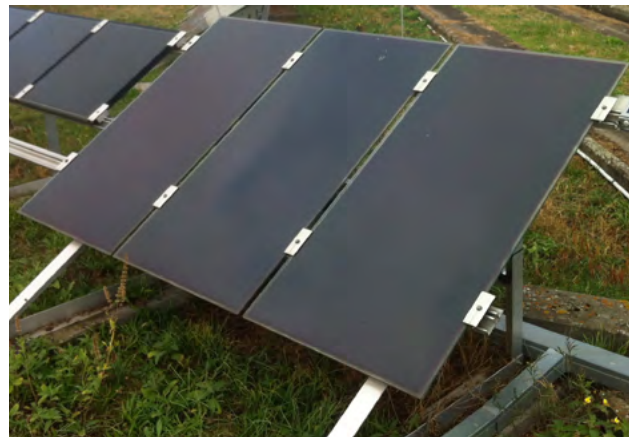
Figura 129. Estrutura de suporte autoportante.
