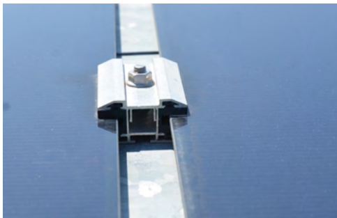
Figura 127. Grampos laminados com borrachas EPDM.
