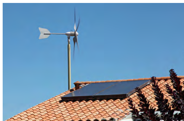
Figura 53. Sistema Híbrido 3 - Eólica-solar
