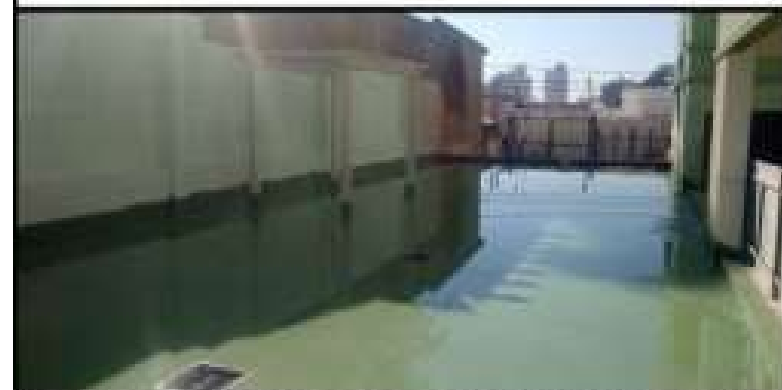
TESTE DE ESTANQUEIDADE - MANTA LÍQUIDA / LAJE
