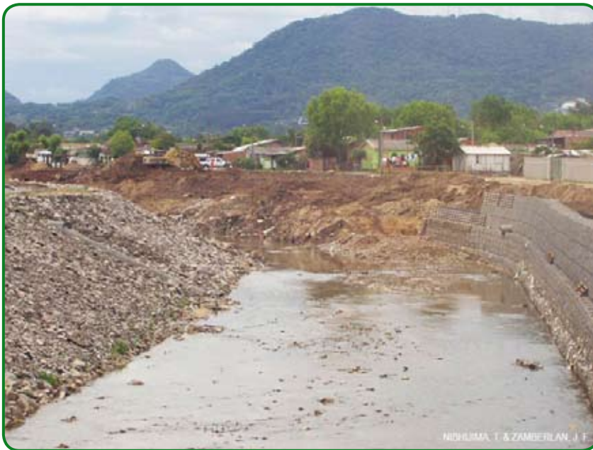
Figura 9.3 – Obras de contenção das margens de um curso d'água em uma área urbanizada.
