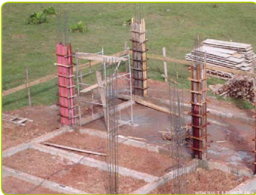
Figura 2.1 – Fundações e pilares de uma edificação em construção.
