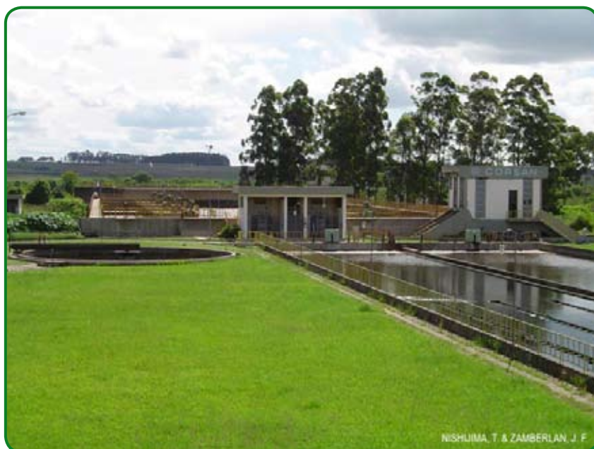
Figura 8.5 – Vista de uma estação de tratamento de esgoto.
