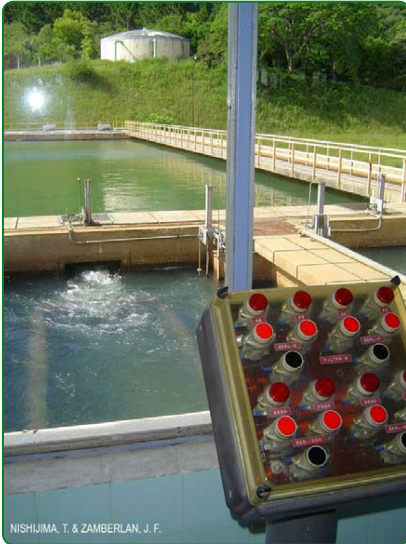
Figura 8.1 – Vista de uma estação de tratamento de água.
