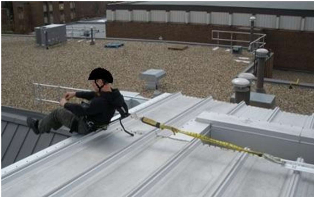
Figura 17. Em um sistema de restrição de movimentação, o comprimento do talabarte deve impedir que o tronco (região dos ombros até a pélvis) passe da borda. Fonte: Small, 2013 [47]
