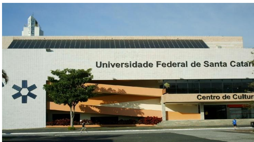
Figura 6.16 - Sistema FV plano inclinado a 27°N, com 10,24 kWp, integrado ao Centro de Cultura e Eventos da UFSC (Sistema de referência). Fonte: Grupo Fotovoltaica/UFSC.
