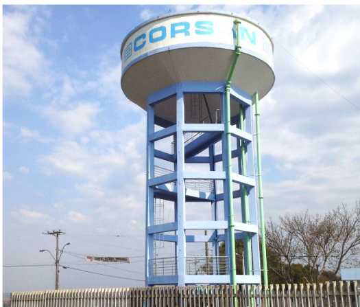
Macromedição: leitura na saída de reservatórios. Volume produzido.
