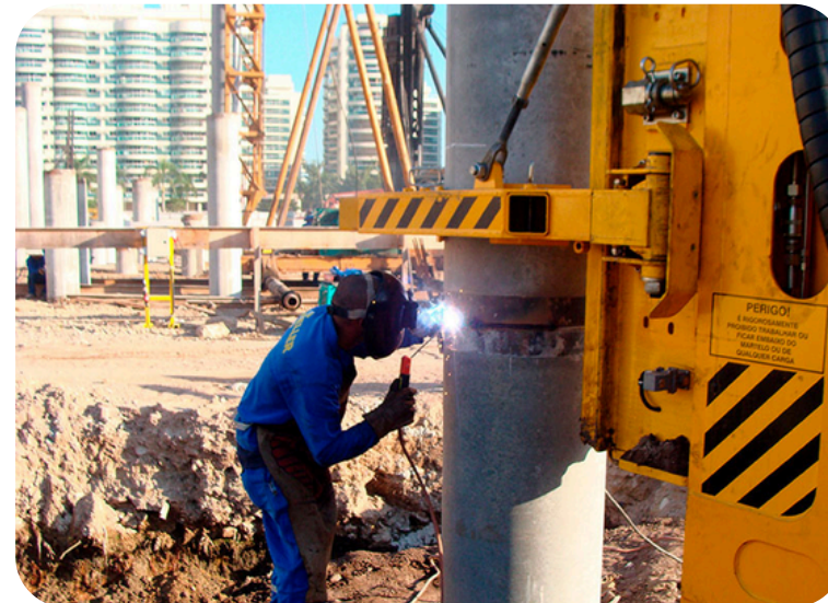
Equipamentos de solda e corte
