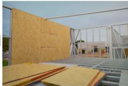
Placa OSB típica e montagem de placas em obra, respectivamente
