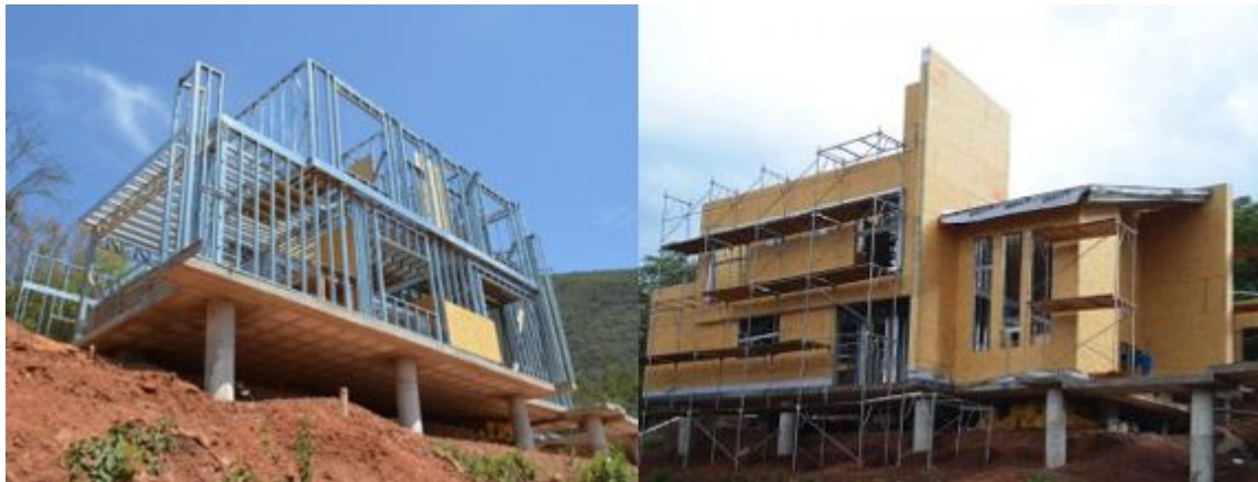
Estruturas em LSF sob base suspensa
