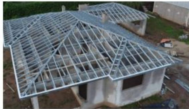
Cobertura em LSF finalizada
