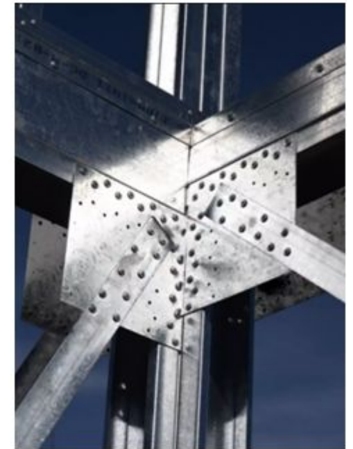
Colunas de contraventamento em “K” e soldagem/fixação dos perfis diagonais, respectivamente
