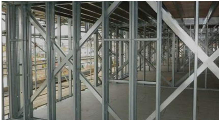
Contraventamento em “X”
