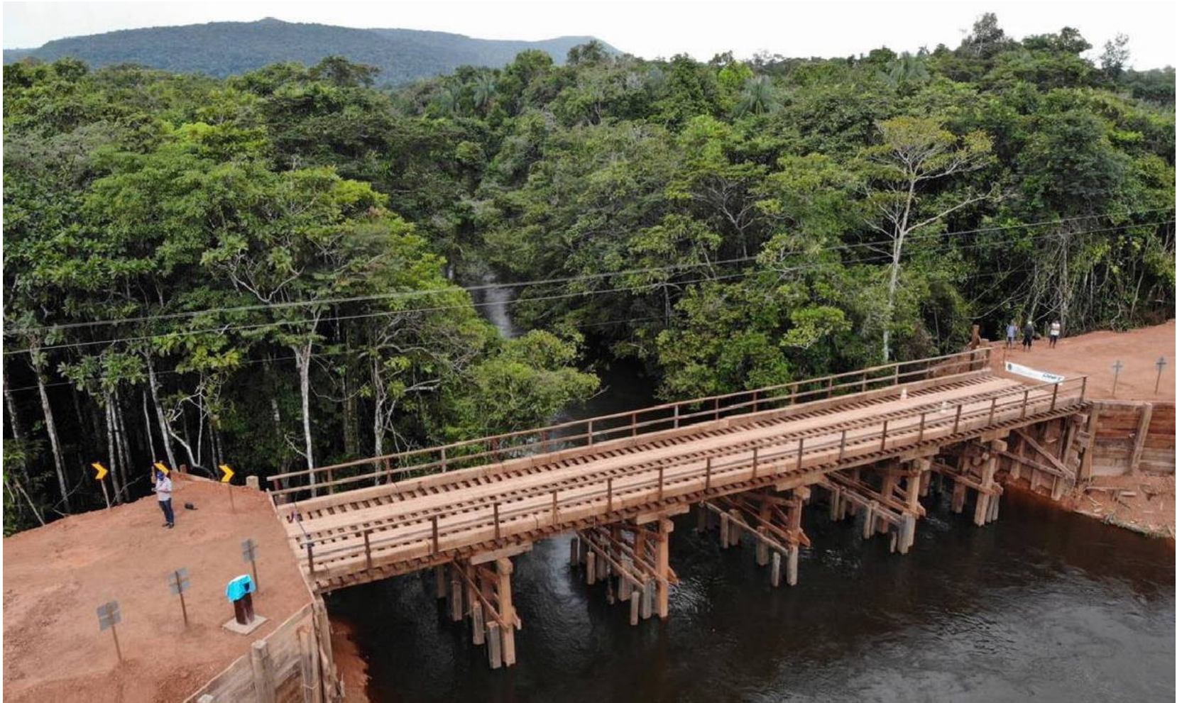
São Gabriel da Cachoeira (AM) 21ª Companhia de Engenharia de Construção do Exército.
