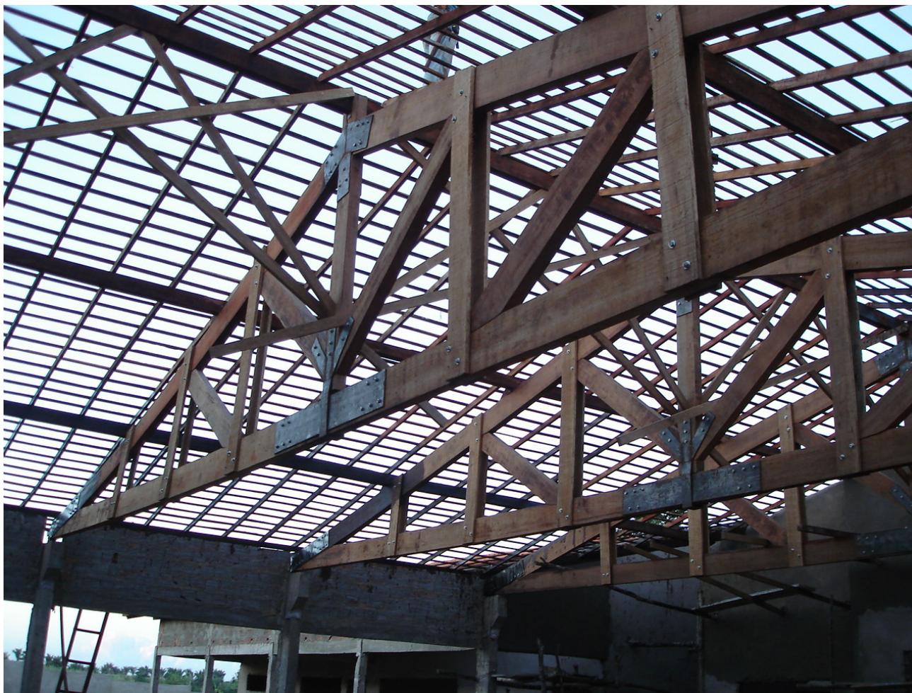
Treliça de cobertura – Joselândia - MA
