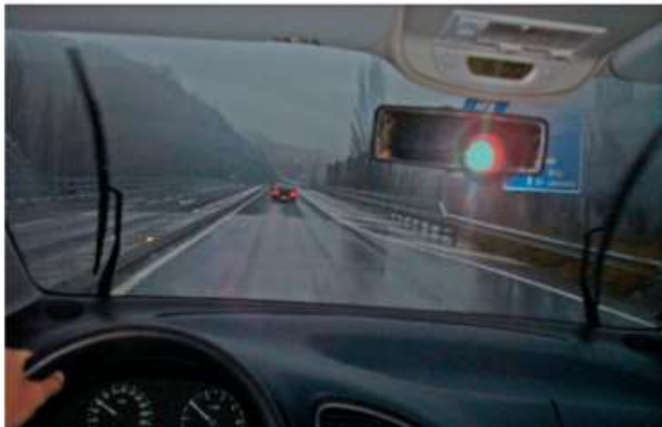
(a) Trecho em CA seguido por trecho em CPA
