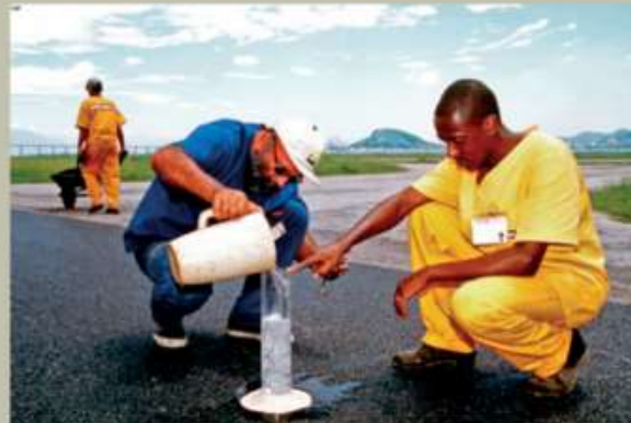
(b) Realização de ensaio de permeabilidade
