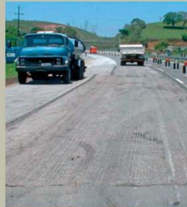
(b) Pista após fresagem
