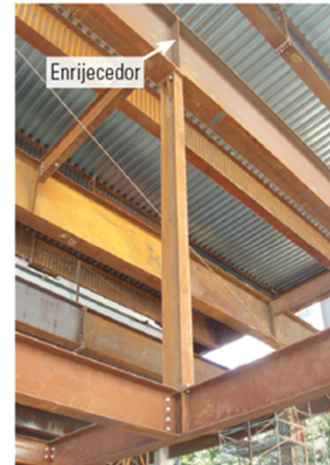
(b) Pendural ligado na face inferior de viga
