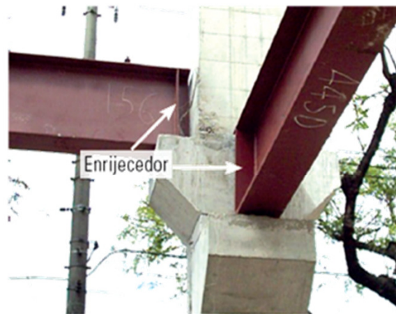
(a) Reação de apoio comprimindo a alma
